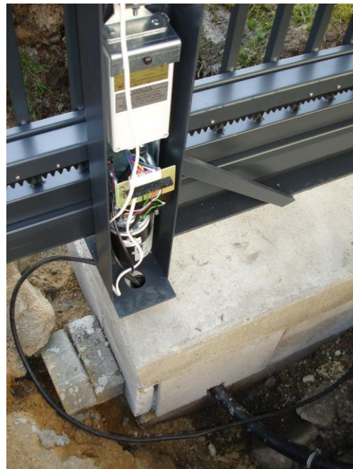
Anschluss an Elektrik
